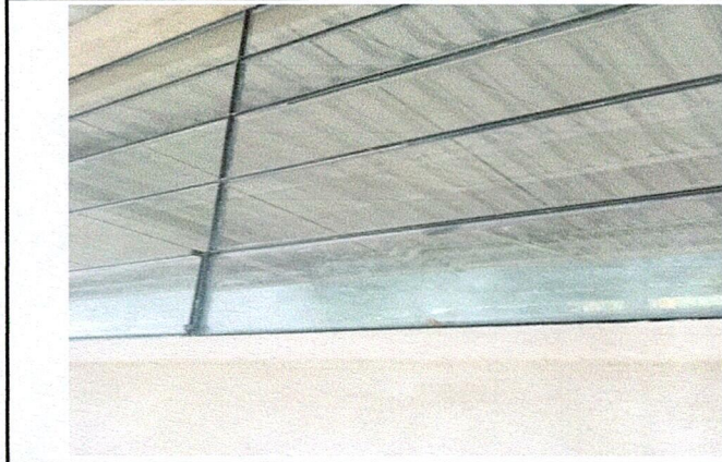
Foto 1: Colocación final de ventanas frontal del aula Adicional
