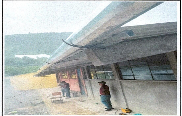
Foto 4: Finalización Instalación Canaleta caída de agua Adicional
