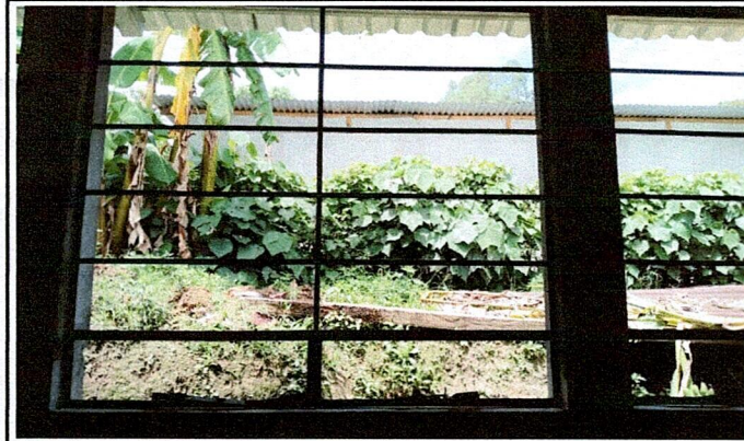
Foto 3: Colocación final de ventanas de atrás del aula Adicional
