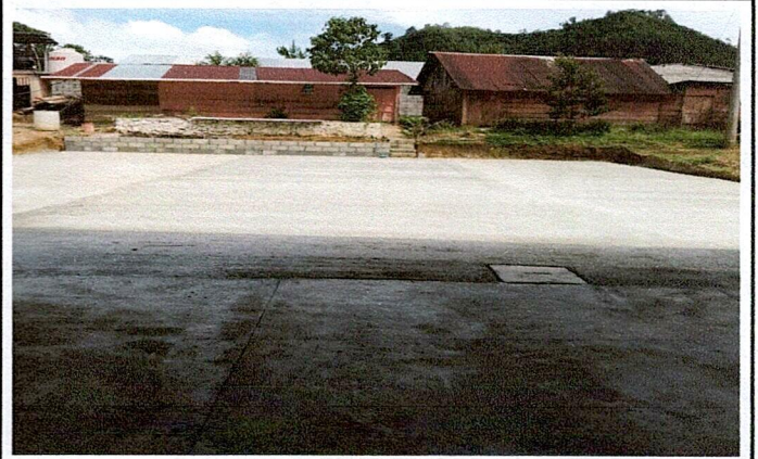
Foto 2: Finalización piso en patio
