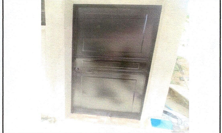
Foto 2: Instalación final de puerta al aula Adicional
