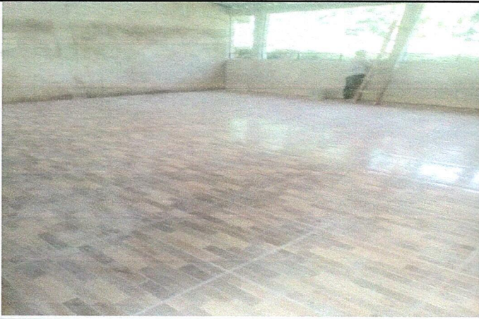
Foto 3: Finalización torta piso aula, adicional piso cerámico
